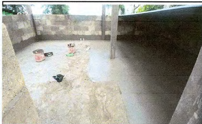
Foto 2: AVANCE DE LOSA DE PISO
