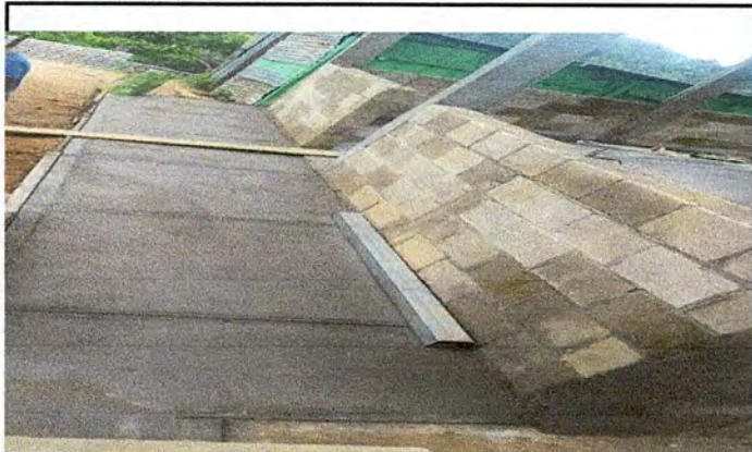
Foto 1: AVANCE DEL MEJORAMIENTO PORTICO
